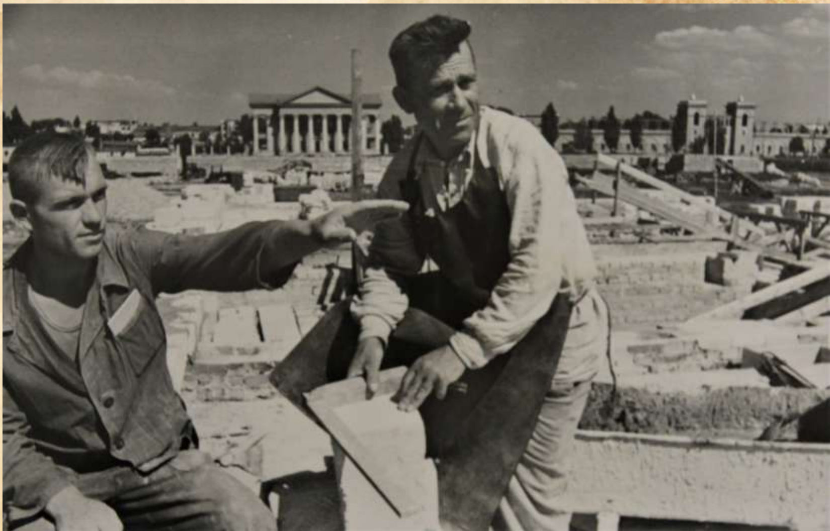
Бригадир комплексной строительной бригады СМУ № 1 треста «Ставропольпромстрой», герой Социалистического труда тов. Волобуев А.А. на строительстве Дома Советов. 1958 год.
