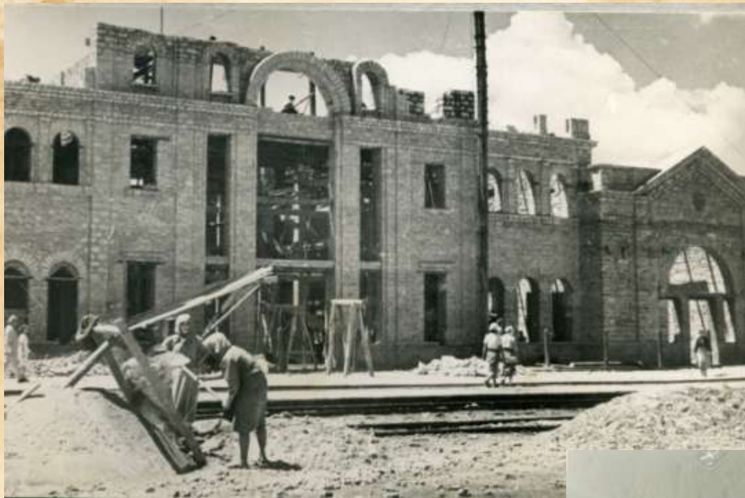
Восстановление жителями города Ставрополя разрушенного во время немецко-фашистской оккупации здания железнодорожного вокзала. 1950-1951 г.г.
